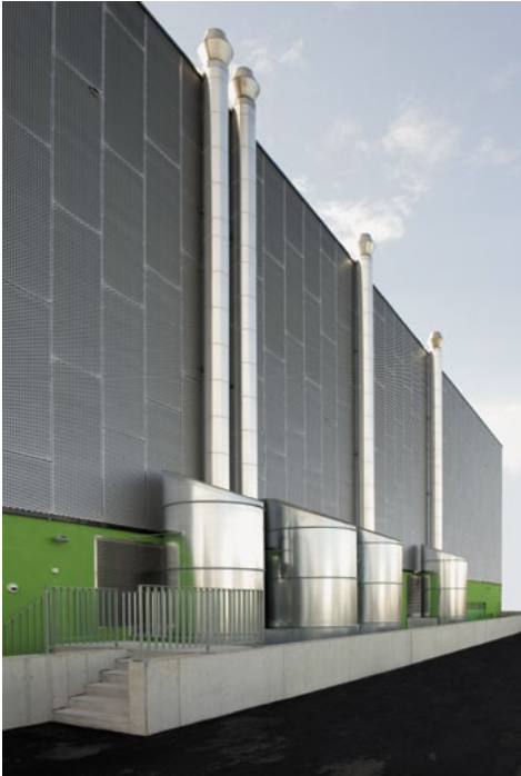
Hochverfügbares Unternehmensrechenzentrum im 70 Kilometer entfernten greenDatacenter Zürich-West.
